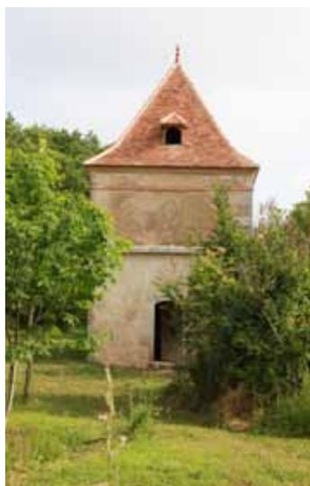
Exemple de mise en œuvre des tuiles plates (toiture) et tuiles canal (arêtiers), produites à la tuilerie de Condat, sur un pigeonnier à Moirax.
