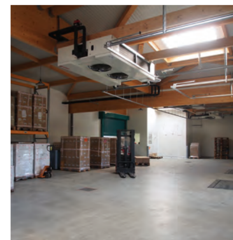
Une attention particulière a été accordée à l'éclairage naturel : grands ensembles vitrés, lanterneau dans les halles de stockage.
