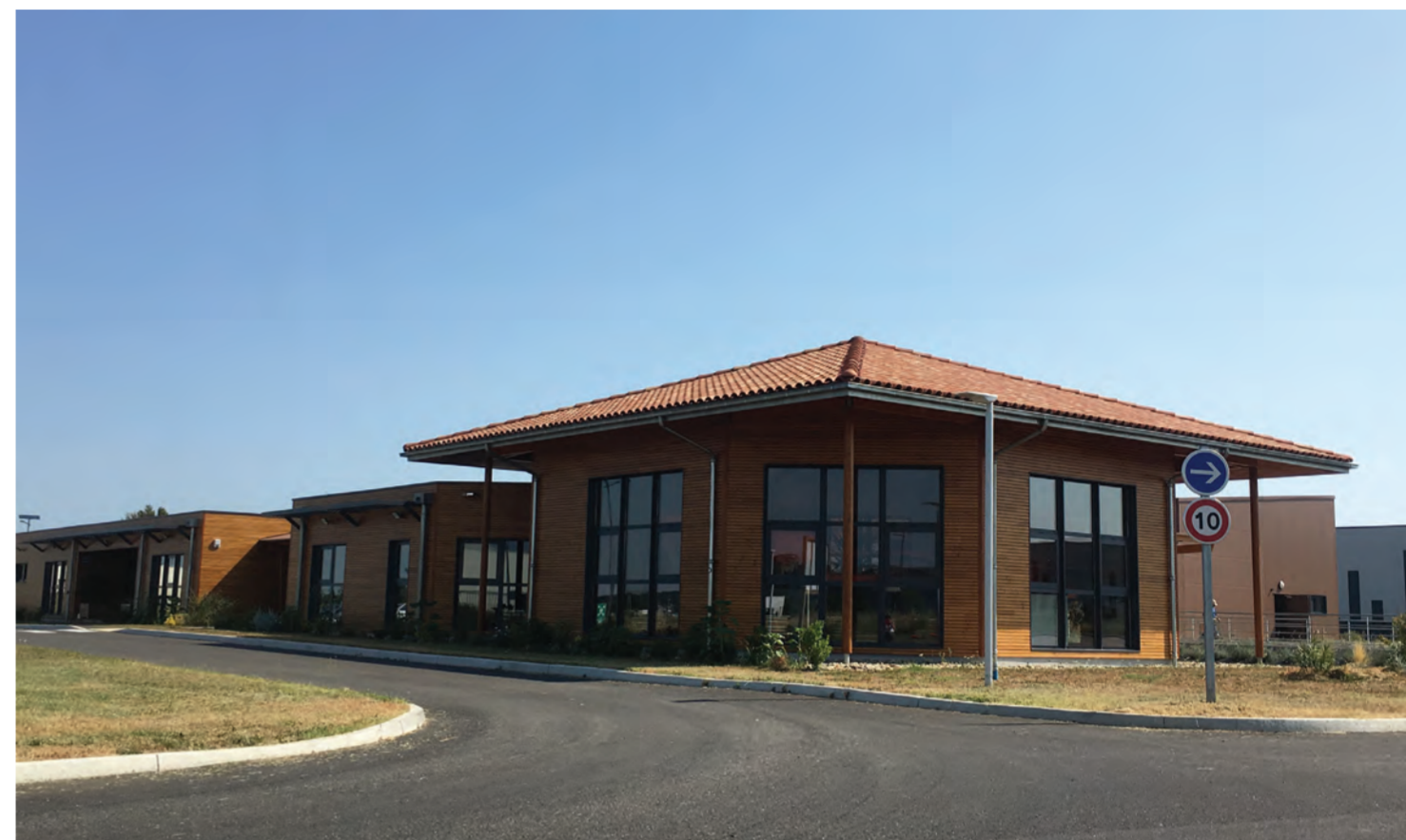
Visible depuis la rue, les bâtiments dédiés aux activités administratives sont en vêtture bois, la salle des ventes de forme hexagonale est dotée d'une charpente bois en lamellé-collé.
