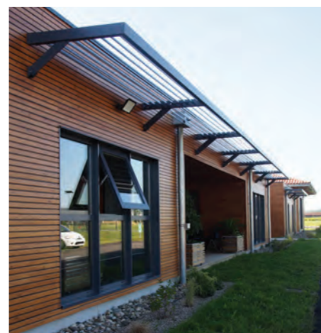
Des casquettes métalliques protègent les façades des apports solaires.
