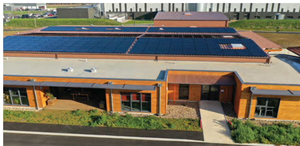
La couverture des différents volumes (salle de charge, réception des marchandises et bureaux) joue sur trois registres : étanchéité sur toiture-terrasse, bacs-aciers et tuiles.
