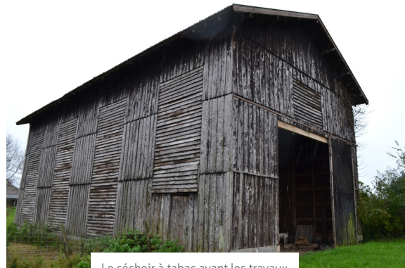
Le séchoir à tabac avant les travaux
