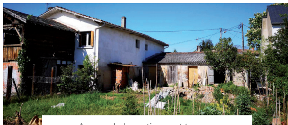
Aperçu de la partie avant travaux
