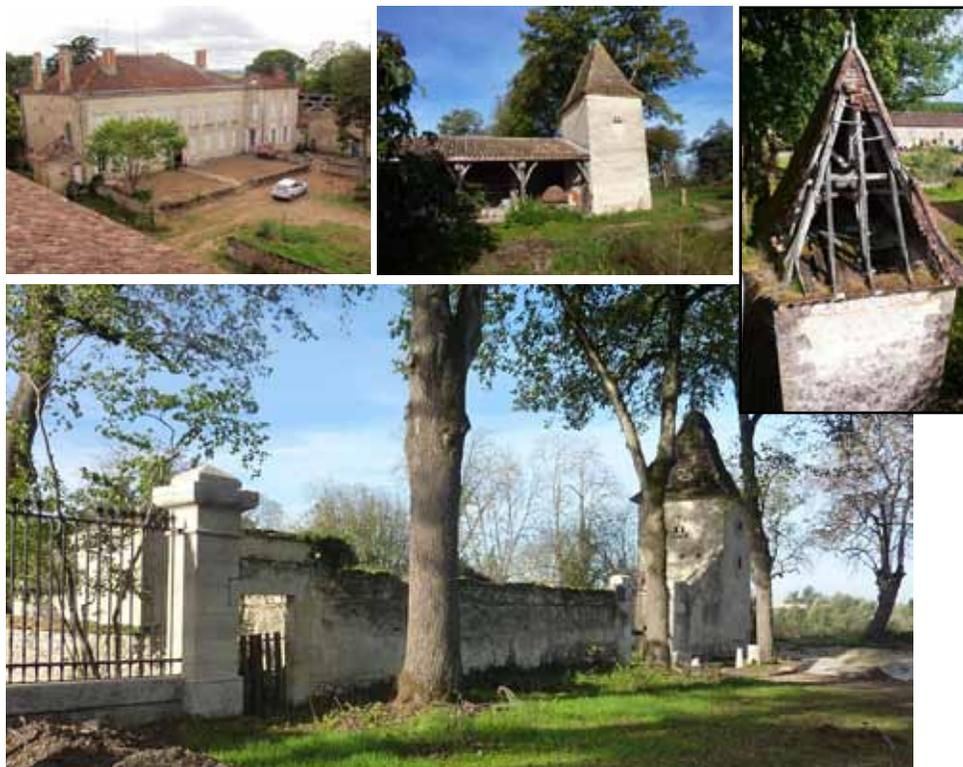
L'entreprise de maçonnerie, pour sa part, reprendra la génoise en utilisant des tuilots de récupération et reconstituera le couronnement du mur de clôture. Les enduits dégradés seront réparés en raccordement de l'existant, ceux de bonne qualité seront nettoyés par brossage doux et les fissures ainsi que les trous seront rebouchés. Certains enduits seront laissés à pierre vue. Enfin, un lait de chaux d'uniformisation sera appliqué sur l'ensemble.
