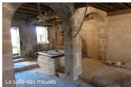
**Nature des travaux à réaliser /** Les chantiers de bénévoles initiés par l'Association avec l'appui de la commune vont se poursuivre : après la restauration d'un muret à l'entrée du site, celle de la Salle des Meules se poursuit : reprise de l'enduit des murs, reprise de la base des meules et de l'encadrement des fenêtres,.... La salle adjacente fera l'objet des prochaines interventions.
