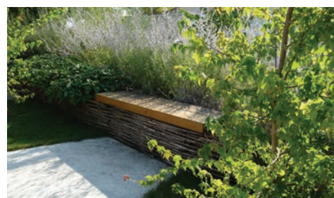
Banquette en bois, fascines d'osier tressé
