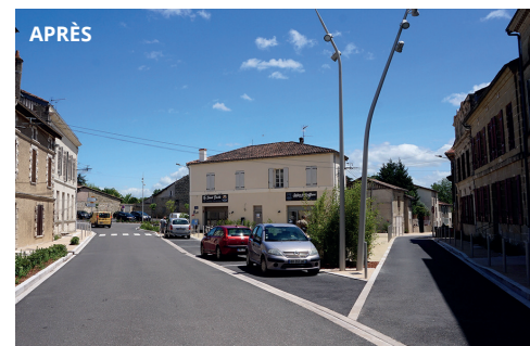
L'intervention a restructuré la place : déplacement du monument aux morts, rénovation de la façade commerciale, création d'une terrasse, redimensionnement des voies et sécurisation du cheminement piéton.
