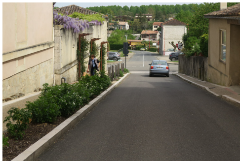
La rue du Château est dégagée du stationnement latéral et recalibrée grâce à l'usage de matériaux variés. Les pieds de façade sont soulignés par des dalles calcaires. La place est redonnée aux piétons dans la montée vers le château.
