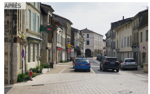
La chaussée de la rue Mazelier (désormais à sens unique) est mise à niveau et requalifiée avec des matériaux variés, des frontages végétalisés et un travail sur les seuils.
