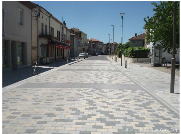
Calepinage de bandes transversales en béton désactivé
