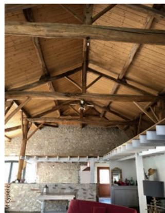
Les dimensions et proportions de l'ouverture existante et la porte de la grange sont conservées et associées à un élément contemporain (baie vitrée en aluminium). L'aménagement intérieur valorise le vaste volume de l'ancienne grange et sa charpente. Architecte M.Cypiere.
