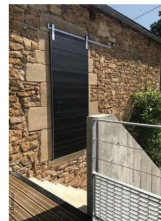
Un escalier, une terrasse sont parfois des rajouts nécessaires. Ici ces éléments sont dessinés par l'architecte avec l'emploi de matériaux contemporains : béton et acier galvanisé. Architecte V.Devaux
