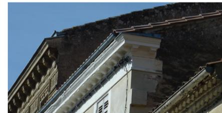
La corniche ou la génoise porte la couverture au-delà du mur pour éviter le ruissellement de la pluie sur celui-ci. Ce couronnement termine la façade.
