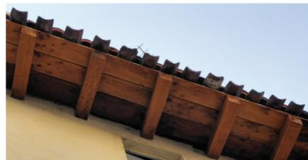
L'égout du toit doit faire l'objet d'une attention particulière. La tuile de courant (tuile baveuse) présente un débord qui sert à éloigner les eaux de pluie du mur de façade.
