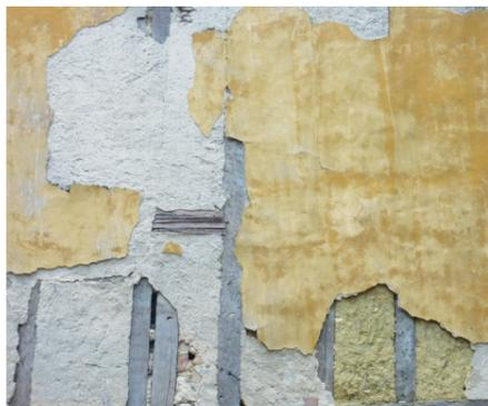
Le torchis (terre et paille), parfois remplacé par de la brique, est employé en remplissage et recouvert d'un enduit lisse.
