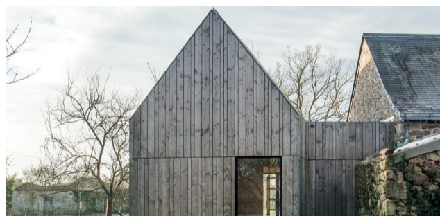
Extension de maison - Saint-Etienne-de-Montluc - Loire-Atlantique - Agence Magnum ©Patrick Miara
