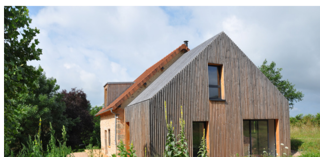
Extension d'une bergerie - St-Hilaire-en-Morvan - Nièvre - ©L'atelier de Montbard
